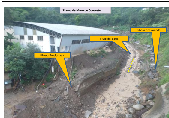
Figura N° 03: Tramo crítico (erosion de talud) en quebrada El Limon, en la temporada de maximas avenidas hace desastres y daños a defensas ribereñas, la cual puede afectar a la población aledaños y agricultura, en el sector Canchaque, vulnerable a la velocidades erosivas de la quebrada, Prog. (4+640 - 4+920)
