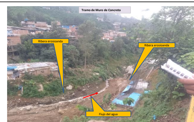
Figura N° 04: Tramo crítico (erosion de talud) en quebrada El Limon, en la temporada de maximas avenidas hace desastres y daños a defensas ribereñas, la cual puede afectar a la población aledaños y agricultura, en el sector Canchaque, vulnerable a la velocidades erosivas de la quebrada, Prog. (4+920 - 5+180)
