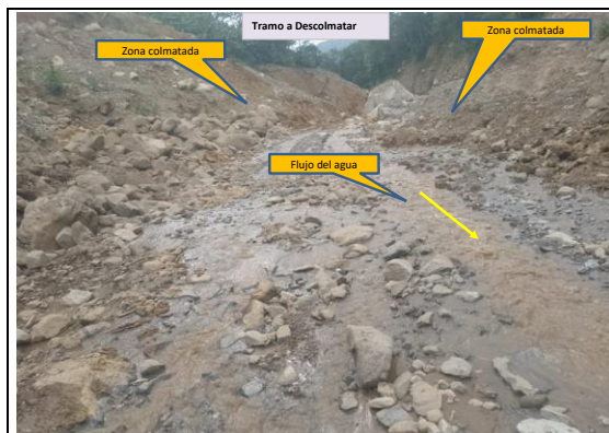
Figura N° 01: Tramo crítico (colmatado) en la quebrada El Limon, en la temporada de maximas avenidas hace desastres y daños a defensas ribereñas, la cual puede afectar a la población aledaños y agricultura, en el sector Canchaque, vulnerable a la velocidades erosivas de la quebrada, Prog. 4+040 - 4+120.
